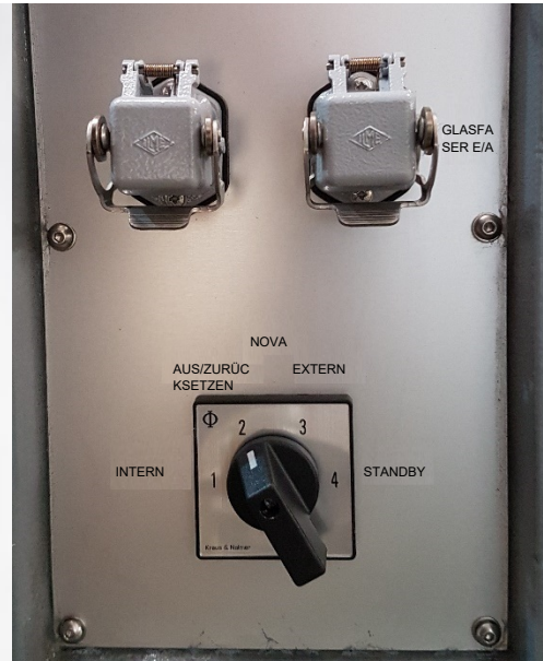
Abbildung 29 – Armaturentafel für den Glasfaseranschluss
